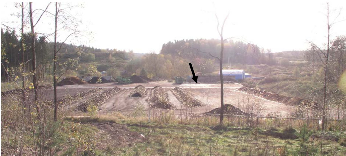
Bild 1. Komposteringsanläggningen på Bälinge avfallsstation sedd från norr. På en platta vid pilen på bilden tippas påsar med hushållsavfall. Fragmenterade påsar med färskt avfall läggs sedan i strängar där de blandas med flis och får kompostera.
