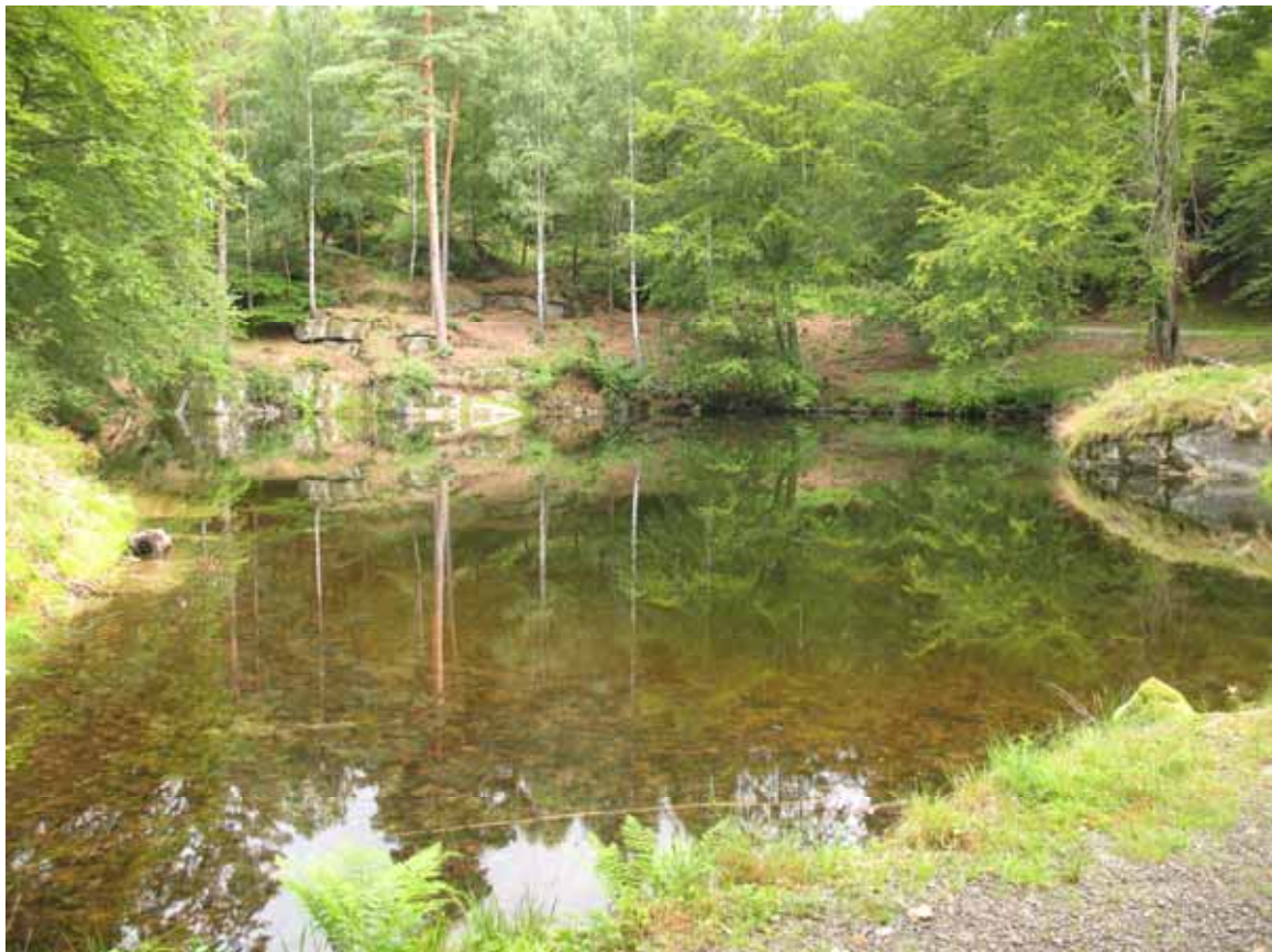
Dammen sedd från SSV.
