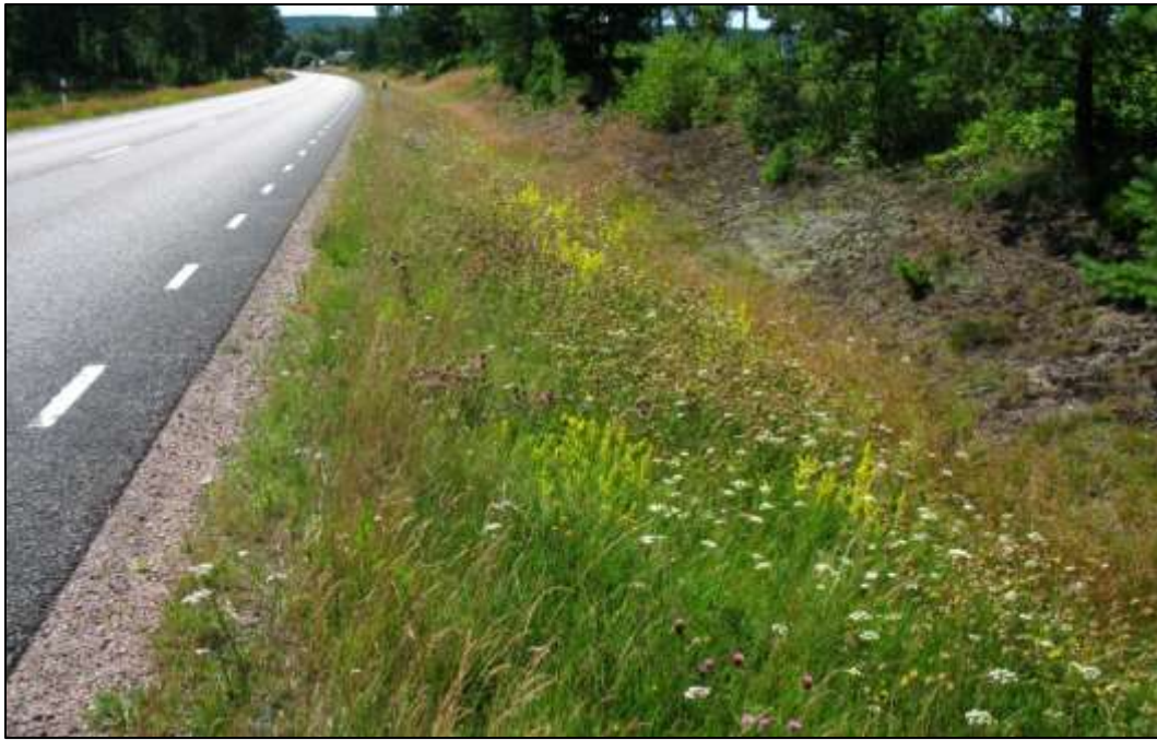
Figur 12. Vägkant 195-07a-v mot söder. Blomrik innerslänt och sandig ytterslänt.
