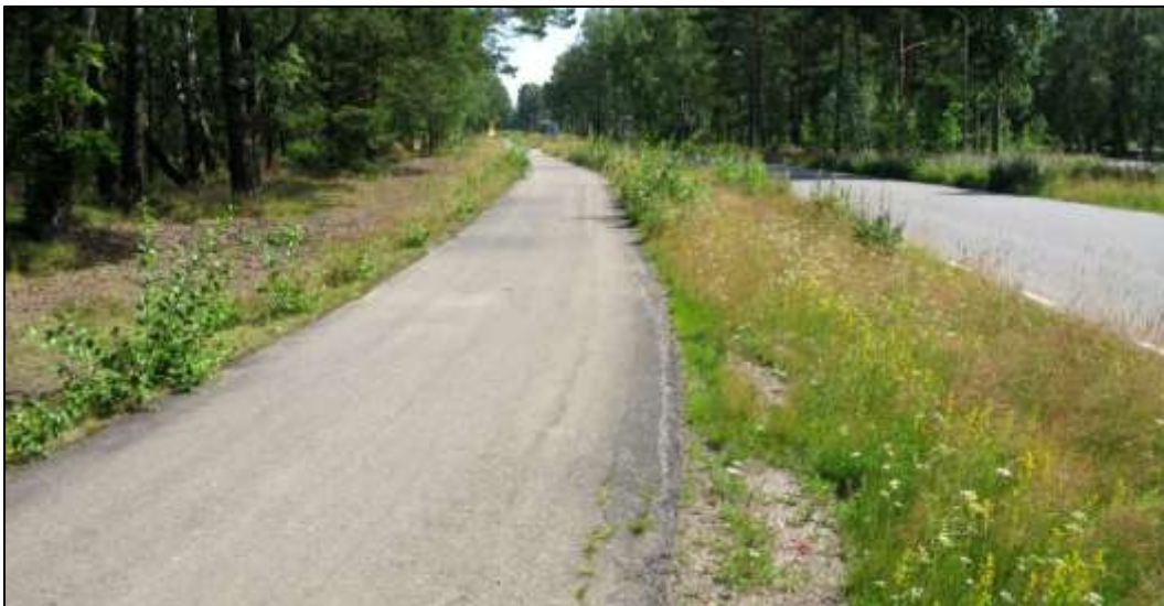
Figur 9. Vägkant 2918-01a-n mot öster.
