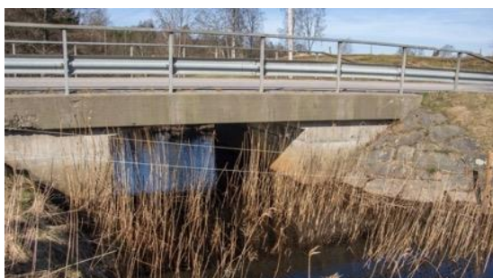
Landsvägsbron strax innan utflödet av Gamlarydsån till Högvadsån. Som så ofta för vägbroar är den för trång vilket kan begränsa flödet. Dessutom är den ett hinder för uttern som inte vill simma under broar utan går upp på land. Om det inte finns en landremsa att gå på tvingas de i stället att gå över vägen vilket innebär risk för påkörning. En lösning på detta är att montera en hylla på fundamentet som uttern kan gå på. 2020-03-25.
